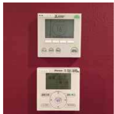
操作は簡単。上の操作パネルは温度やタイマーの設定。下は除湿・加湿・換気の切り替え。室内3箇所のセンサーと連動している。
